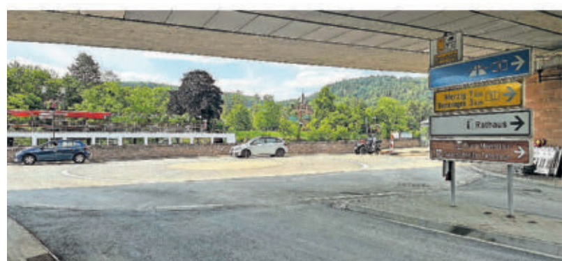
Der Kreisel in Mettlach musste nach dem Pfingsthochwasser gesperrt werden und wurde nun wieder freigegeben.
